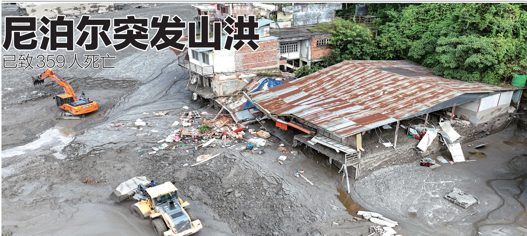
在尼泊尔努瓦果德县的德里苏利,救援人员利用挖掘机清理淤泥(无人机照片)。
