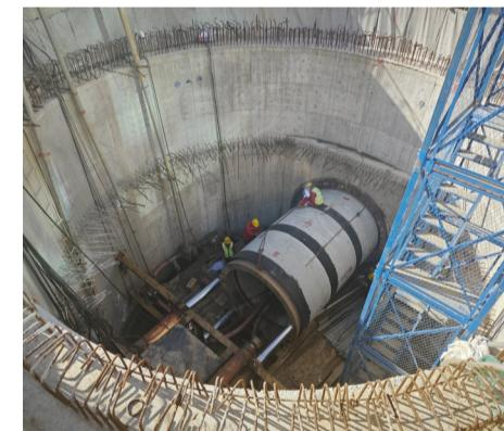
本报讯(YMG全媒体记者 杨春娜 通讯员 魏元海 王浩瑞 摄影报道)5月26日上午,由中铁十局青岛公司承建的朝阳站胜利路北马路段电力管廊工程3#-2#段顶管施工经过18个日夜的连续奋战,顺利完成了出洞作业,这标志着整个工程地下顶管全部完成,项目正式进入工作井主体结构施工阶段。
