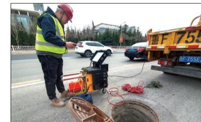
本报讯(YMG全媒体记者 杨春娜 通讯员 曲敏 邵红艳 摄影报道)昨天,市城管局城市排水服务中心开始对辖区内排水设施进行清淤养护。除了人工清挖之外,内窥镜、管道机器人等先进设备上岗,对沿河污水主管网、过河支管、截流设施的结构及功能性状况开展全面排查。
