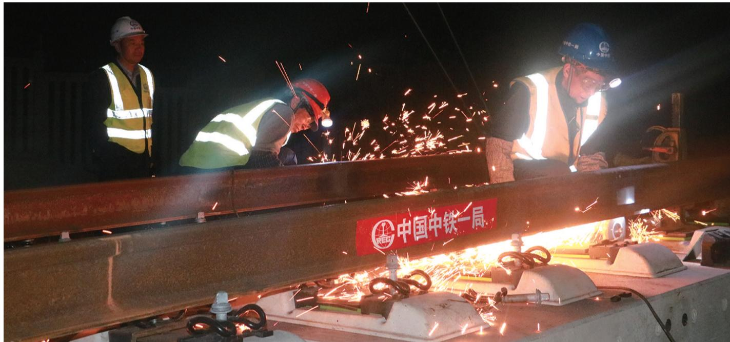
本报讯(YMG全媒体记者 杨春娜 通讯员 张路军 摄影报道)昨天上午，在潍烟高铁蓬莱至芝罘段施工现场，移动闪光焊机组正在对钢轨连接头进行闪光焊接和焊后正火处理。经过反复拉伸、撞轨和观测，一条条500米的长轨变为1500米，再变为整体无缝线路，成功完成锁定。“锁定轨温要达到25℃以下才可以进行应力放散施工。”中铁一局潍烟铺轨工区负责人曹德志说，中午气温达不到应力放散施工的要求，工人就在夜间进
