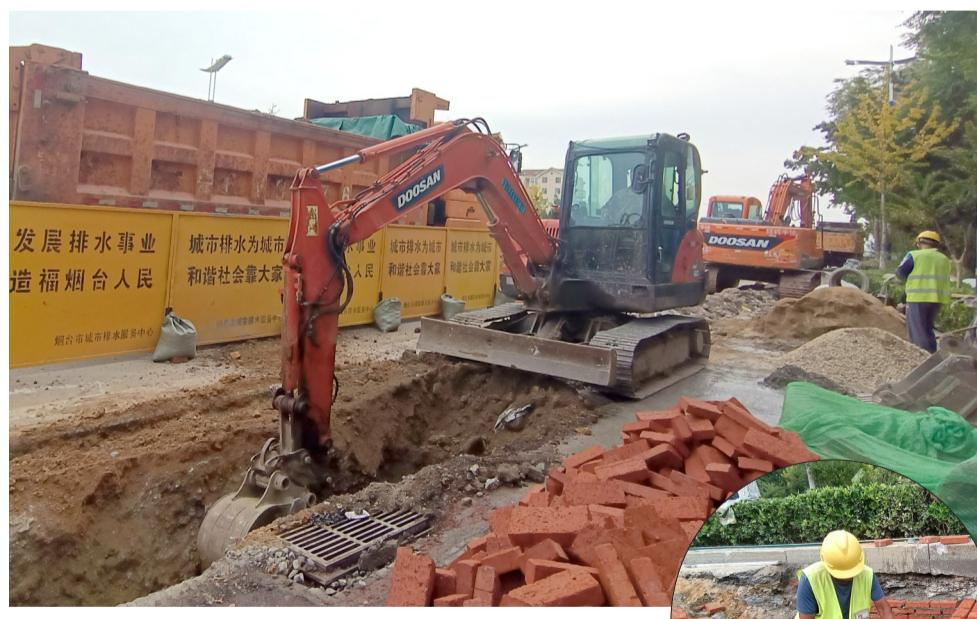
横”排水设施及雨污水管网进行了摸排清查,发现雨污水管网老旧设施比例高,存在设施老化、腐蚀、破损、下沉、不完善等问题。此次改造工程涉及主体多、施工难度高,为了确保施工安全,部分道路需要进行半封闭施工。排水服务中心施工人员根据施工点位
