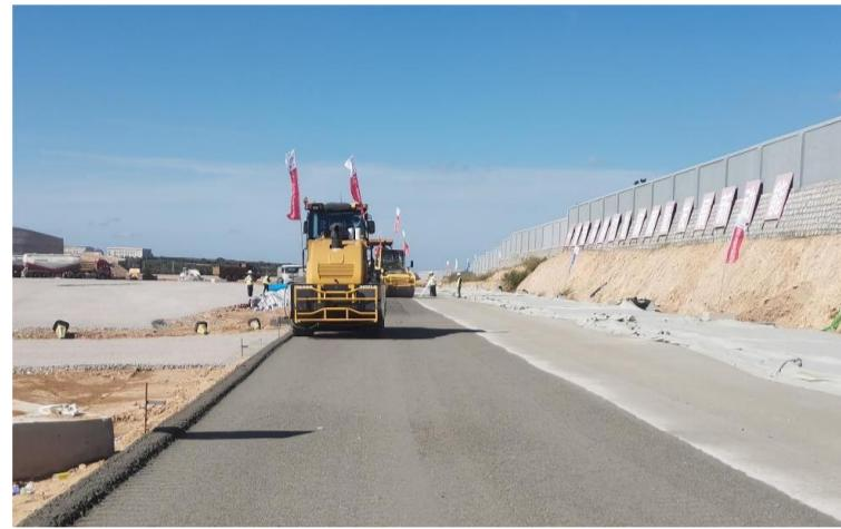
本报讯(通讯员 黄程飞 万广迪 摄影报道)9月20日,中交一公局第五工程有限公司山东一路交通智能网联测试场项目水稳试验段摊铺完成。
