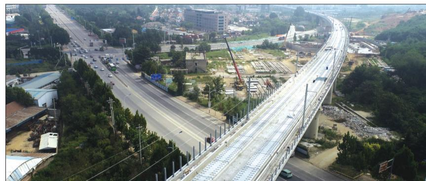
自主研发的新型CRTS III型板式无砟轨道,累计铺设及精调轨道板共12206块。
