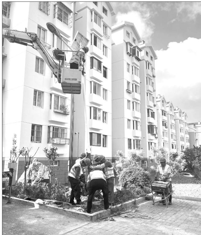
为卫生间返水。维修师傅对该楼道的部分下水管道进行维修，并对下水管道淤堵进行疏通。经过两个多小时的维修疏通，污水管排水恢复了畅通。
