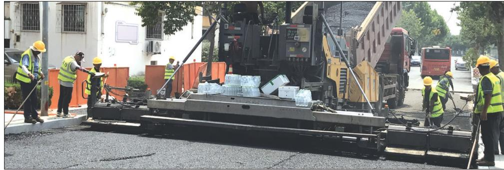
路紧邻居民小区，给小区居民出行造成极大不便，成为居民的一件烦心事儿。芝罘岛路西起幸福路，东至芝罘岛东路，道路沿线两侧为住宅区，道路全长794米、全宽7.9—26.1米，车行道宽9米，两侧人行道宽2—3米，采用双坡向直线型路拱，全线道路为改建工程。道路施工内容包括强电、弱电入地管线施工，雨污分流改造以及部分燃气管线改造施工，目前，该道路已经完工通车。佳苑北街西起芝罘岛西路，东至芝罘岛东路，道路沿线两侧为住宅区，道路全长889米，车行道宽8—10.5米，两侧人行道宽1.2—10米，采用双坡向直线型路拱，全线道路为改建
