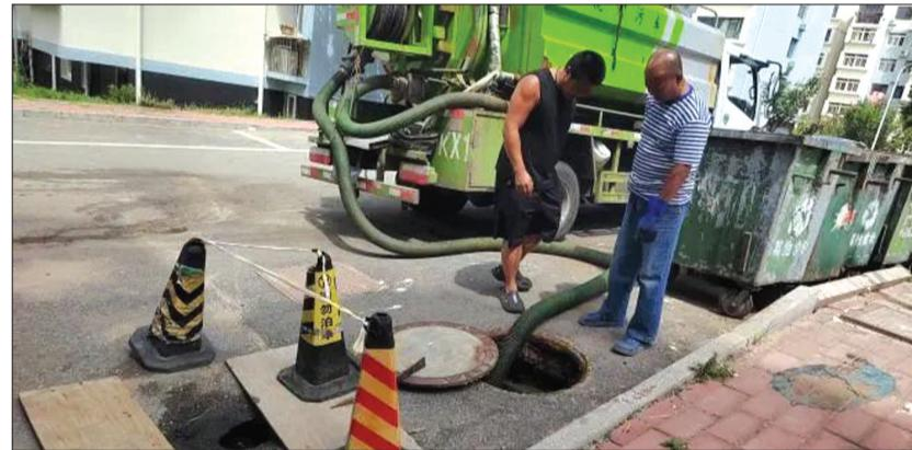
破裂导致地面塌陷，同时管道破裂也致使化粪池淤泥无法吸出。工作人员针对该问题重新制订修复方案，很快完成了管道更换，并将路面回填加固完毕，彻底消除了安全隐患，保障了小区居民
