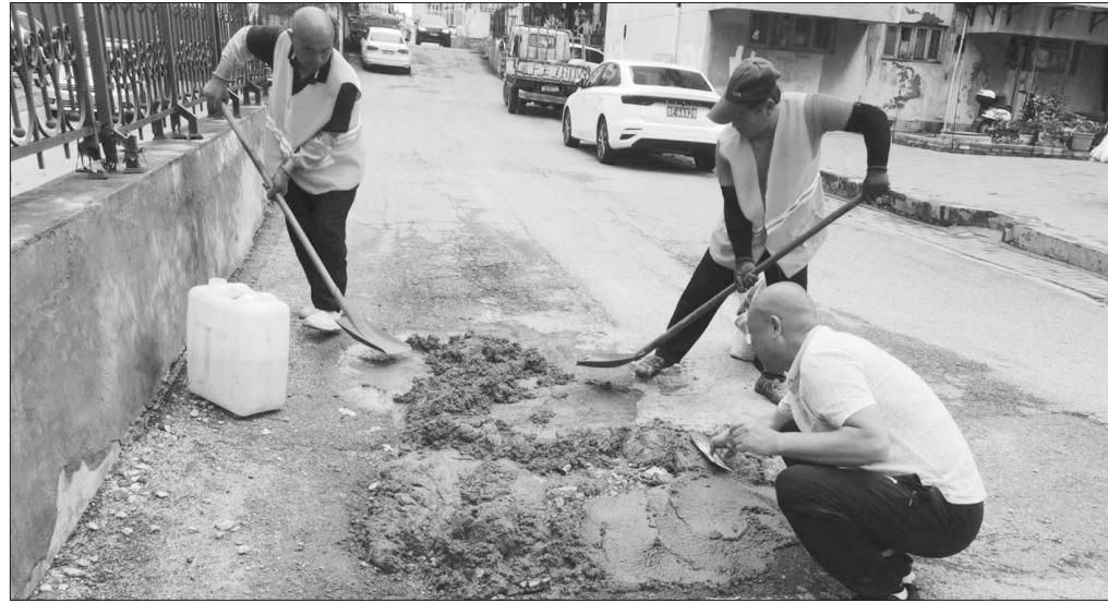
小区路面破损情况进行排查登记,并上报40余处破损点位。为解决难题,中台社区党委找到辖区共建单位众志供水公司,在多次现场沟通,制定解决方案后,工人们带着维修物料和工具来到现场,拆除塌陷的路面砖头和水泥块,平整路面后用水泥将修复路面进行加固。经过近4天的维修施工,共修补破损路面41处、地砖塌陷10余处,小区路面恢复平整干净,居民们出行
