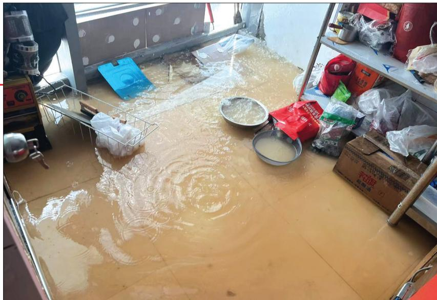
经历这样的事情。他说，今年4月份的一天上午，物业在群里发布了消防管道注水试压消息后10分钟左右，自家店便开始漏水，因为当时毫无准备所以损失非常惨重，冰箱里的贵重食材以及机器都被水泡了，损失高达几万元。事后，他打电话一遍一遍地催，物业公司派人过来看了看便没了下文，没有相关损失的赔付。“当时注水试压前并没有对设备设施进行检查，如果他们能够早一点检查设备设施，及时更换喷头，不至于发生这样的事，而且发生了两次。”王晓明的女友气愤地说，事后她找到物业公司，对方以消防喷淋头被换过为由拒绝赔付，让她找房东，物业这边只能通过消防保险赔付几千元，“这个数额与我们的损失数
