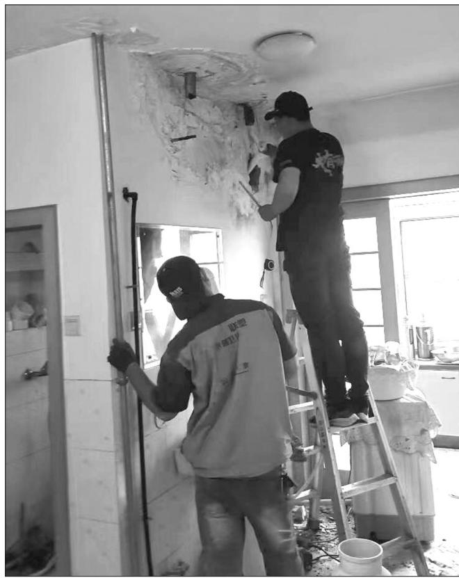
更换，拒绝维修。为长远考虑，防患于未然，经过不断协商，五楼业主最终同意检查维修管道，专业管道维修人员对现场进行检查。经查，四楼楼顶主管道口有漏洞且污水管道设施年份久远，管道内生锈导致管道壁狭窄，时间一长就容易引起堵塞，需对该段污水管道全部进行更换，仅靠修复该漏洞已无法彻底解决问题。为此，网格员积极协调
