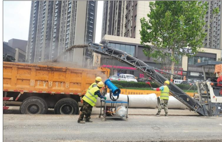
本报讯(YMG全媒体记者 杨春娜 通讯员 祝冉 摄影报道)随着沥青铣刨机的轰鸣声,莱山区清泉路道路排水老旧管网改造正式进场施工。昨天上午,记者来到施工现场,崭新的雨污水管道整齐排列,本次施工主要解决管网老化腐蚀、破损下沉及设施不完善的问题,实现雨污分流,预计7月25日完工。
