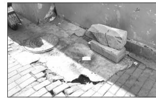
脚，存在一定的安全隐患，希望社区能够及时修复塌陷的路面，还居民主平坦的回家路。接到居民反映后，社区网格员和助理员赶到现场，对该路面进行现场勘查，并保留路面塌陷的照片，同时联系南洪社区的公益组织洪心物业公司。随后，两位施工师傅到达现场，在该路面区域设置安全警示标志，将塌陷的路面砖头和水泥块进行拆除。平整路面以后，又将砖块整齐地铺在了路面上，并用水泥将楼体的边边角角进行加固。施工过程中，网格员和助理员全程进行监督，争取做到最安全、最完美的修复。整个修复过程，仅用了半天时间，修复后的路面平坦整洁、坚固耐用。
