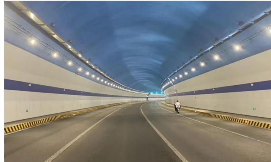
黑黄反光漆粉刷,做到全方位、无死角、精细化维修施工。截至目前,已完成通世路隧道黑黄反光漆的更新粉刷工作。施工过程中,为减少对过往行人和车辆的影
