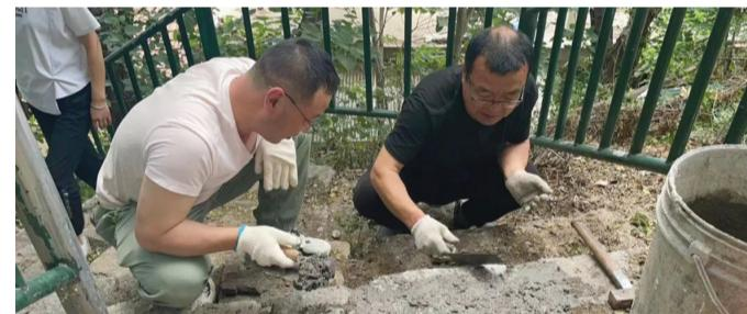
动脱落的台阶安放在原处,用水泥固定好,再将破损处用砂石填埋并用水泥固定抹平。
