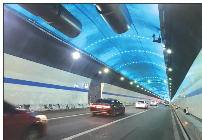
此前，隧道内的供电条件只能满足一般照明使用，如今各类景观灯全部投用，对隧道的供电水平提出了新要求。”王刚介绍，胜利路隧道布设5万余米的10条电缆，新增一台315千瓦时箱式变压器，不但能保障全部景观灯用电，还可为远期隧道其他改造提供电力保障。同时，对隧道穹顶进行全面清洗，并对漏水点位进行逐一修补，实现“一套方案，多重改造”。
