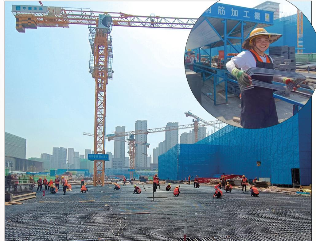
本报讯(YMG全媒体记者 杨春娜 通讯员 杨继伟 摄影报道)昨天上午10:40左右,室外温度超过了30℃。在位于莱山区华庭路的烟台市妇幼保健综合楼项目6区施工现场,36岁的栾孟振正在忙着绑扎钢筋。施工位于车库主体顶板,他只能长时间蹲着作业,汗水滴滴答答落在钢筋上……
