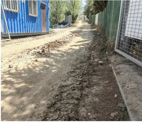
芝罘区红旗西路北侧内部道路积尘明显
