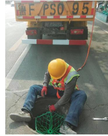
记者看到，警示标志共分两种类型，第一种由浮漂、限位圈、反光锥三部分组成，一旦井盖因泄洪不畅被雨水顶起移位，浮漂会托起反光锥自动弹升，将反光锥顶至路面以上；第二种警示标志是将圆形浮漂用绳索连接固定在防坠网上，浮漂上缠绕多道反光警示贴纸，当井盖移位时浮漂便会被雨水顶起并漂浮至路面以上，两种方式均能达到及时预警目的。
