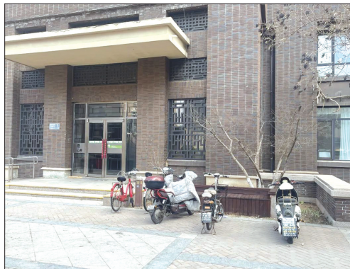
海云台小区1号楼门前,存在非机动车乱停放现象。
