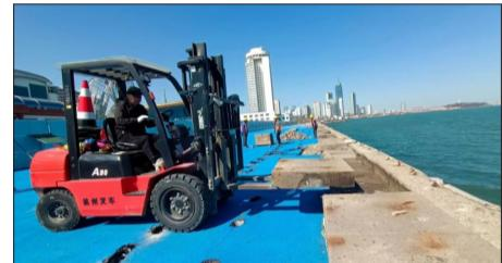
本报讯(YMG全媒体记者 杨春娜 通讯员 刘鹤 张猛 丁淳淳 摄影报道)昨天上午,记者来到旅游大世界广场,看到护岸修复工程已经开工。本次修复将拆除现有破损栅栏板、护面及挡浪墙,新建L型钢筋混凝土挡浪墙,将护岸坡度放缓,向海侧延伸,采用4T扭王字块护面,增强对海浪冲击和侵蚀的抗性,塌陷路面根据原路面结构样貌进行恢复。
