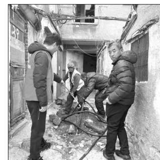
楼下水道堵塞，污水外溢严重影响附近居民、商户以及学校正常生活和出行，得知情况后，社区工作人员立即到现场查看，并紧急协调区排水处，对淤堵现场地下管网进行实地排查。经查，该下水道接口窄，管网老化严重，加之部分居民将各种生活垃圾倾倒于下水管内造成严重堵塞，导致污水外溢。随后，区排水处对污水井进行仔细清掏和疏通，经过近2个小时的紧张作业，下水道大量淤泥及垃圾被清理干净，污水外溢问题得以圆满解决，管道畅通了，居民出行也得到了保障。
