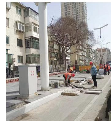
二马路原有人行道道板老旧程度较高,时常可见道板砖裂缝和缺损现象,且人行道入口开放度和坡度设计不合理,不符合国家无障碍人行道标准,给市民出行带来一定不便。本次改造将对原有老旧人行道、盲道全部换新,采用分段施工形式,首先由东向西从金沟寨立交桥到解放路,进行北侧人行道入口坡度及无障碍设施改造。完成后,再由西向东自解放路到金沟寨立交桥,进行南侧无障碍设施改造。
