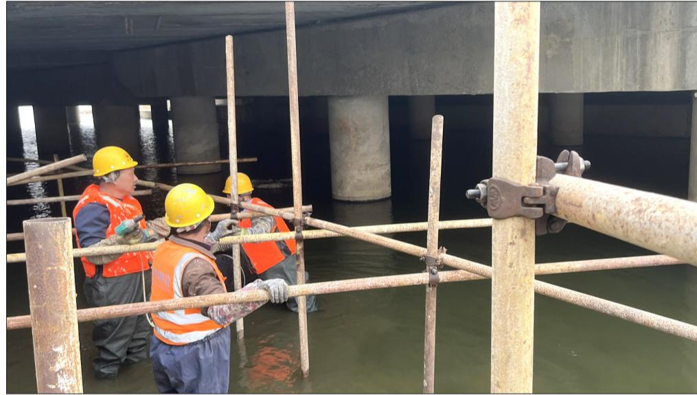
本报讯(YMG全媒体记者 杨春娜 通讯员 王为超 衣起慧 摄影报道)昨天早上,记者来到位于观海路的刘家滩桥,市城管局市政养护中心的一队施工人员正在桥下进行满堂脚手架搭设作业,准备对桥梁进行加固除险施工。
