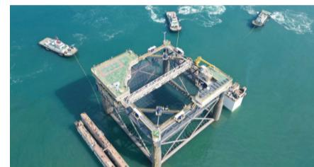
昨日，大型深远海智能网箱平台“经海005号”在长岛南隍城海域完成坐底交付。“经海005号”是山东省智能化程度最高的大型网箱，长宽各68米，养殖包围水体达9.4万立方米，搭载了智能监测、自动投喂、自动洗网等设备，可以让鱼群在类野生环境中生长，年产渔获可达1000吨。
