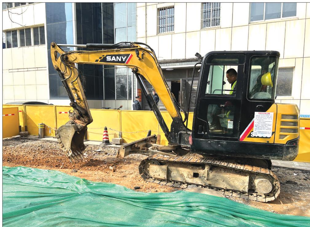
现场，车行道原路面已经破除完成，几名工人师傅正在整理覆盖在上面的绿网，防止施工扬尘。一台挖掘机正在挖掘地下管线通道，工人师傅将运来的管材妥善放置在施工区域内，准备进行地下管线预埋作业。“自2月中旬进场施工以来，目前已完成桃花街南段原车行道破除施工，正在进行强弱电套管铺设、雨污水管线整治改造施工。”中交一公局芝罘项目工区主任姜有鹏介绍，本次改造将对桃花街结构层以上部分进行整体提升改造，调整人行道、车行道宽度，满足通行需求。同时，根据与强弱电管线专营单位对接情况，提前预埋强弱电入地套管、智慧路灯套管，为后期道路范围线缆入地、智慧城市建
