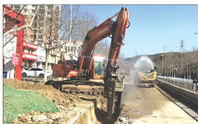
次破路施工,路面打满补丁,存在结构层疲软、路面网裂坑洼等问题。期间,虽然通过小修小补维持使用,但是已不堪重负,存在一定程度的安全隐患。地下管网设施方面,经摸排,存在管线腐蚀破损、沉降错位等问题,而且随着周边小区建设,污水管网已无法满足排放容量要求。另外,还存在雨污混接问题,道路周边的中正山庄、帝景南苑小区雨水管接入魁富路污水管网,汛期多次造成雨水通过污水管溢流,形成短时内涝,周边居民反映强烈。综合考虑,魁富路纳入2023年我区道路改造范畴。
