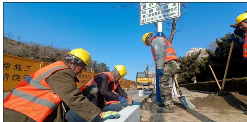
度设计不合理,不符合国家无障碍人行道标准,给市民出行带来一定不便。本次改造将对原有老旧人行道板砖、盲道全部换新,采用分段施工形式,首先由东向西从金沟寨立交桥到解放路,进行北侧人行道入口坡度及无障碍设施改造;完成后,再由西向东自解放路到金沟寨立交桥,进行南侧无障碍设施改造。此外,改造中也将对人行道上的井盖进行处理,统
