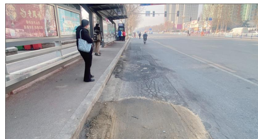
针对存在的问题,记者联系了莱山区市政服务中心。据工作人员介绍,迎春大街养管工作于去年由市城管局养管部门移交莱山区。接手后,莱山区市政服务中心多次对道路沿线进行排查。由于迎春大街公交车流较大,加上去年降水量大,导致公交站前路面坑洼问题增多。莱山区市政服务中心多次安排养护单位对路面进行了修补。由于气温较低,只能用冷料沥青、水泥砂浆等材
