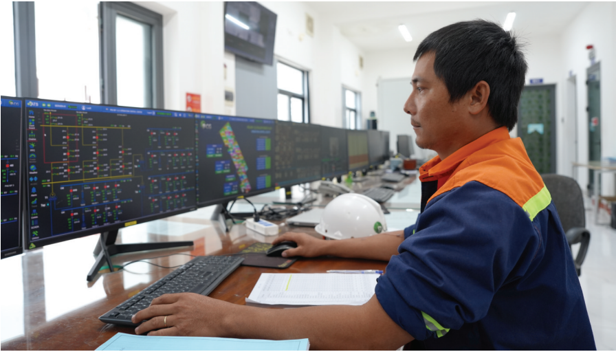
10月13日，在越南嘉莱省，技术人员在富美330兆瓦光伏电站运维中心查看电站运行情况。
