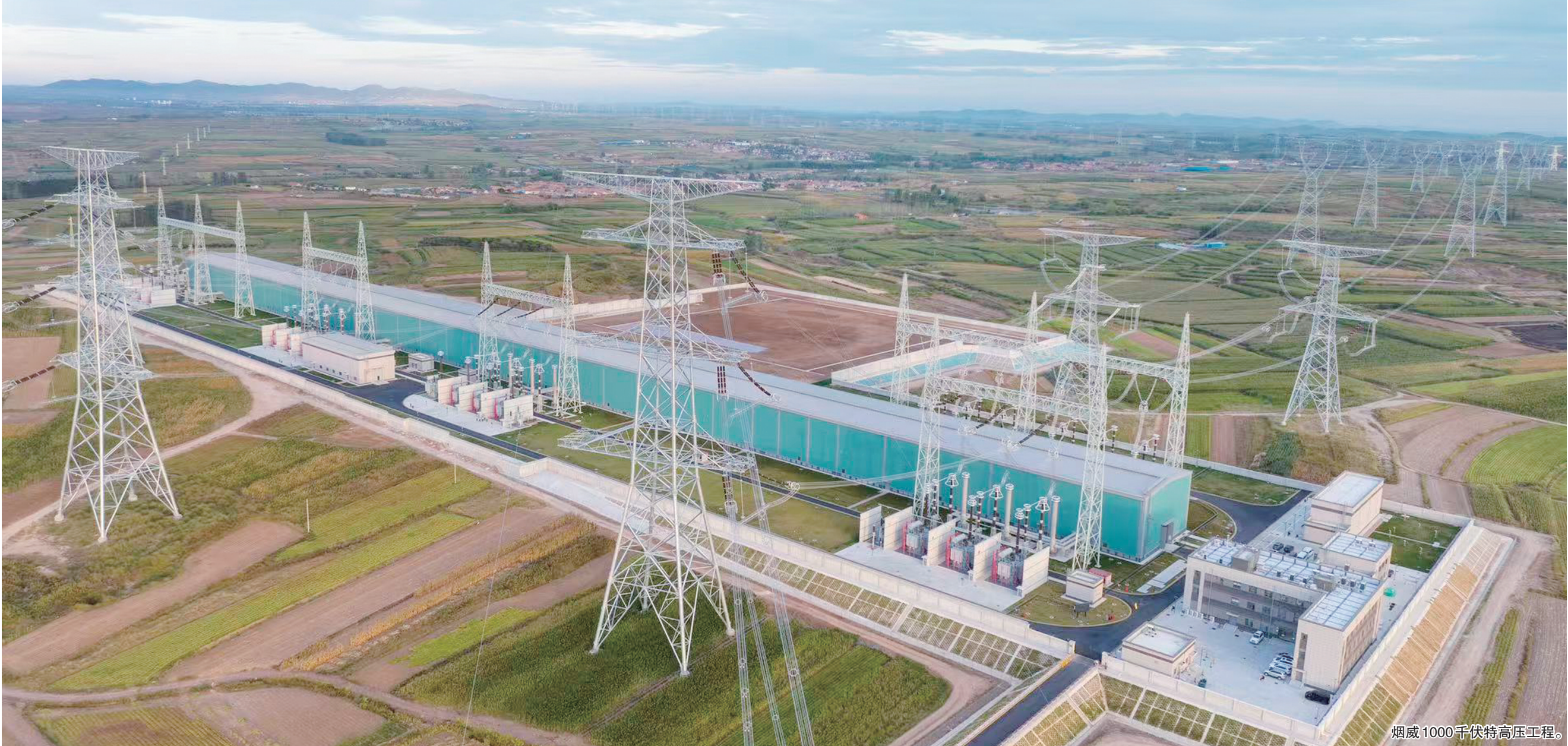
烟威1000千伏特高压工程。
