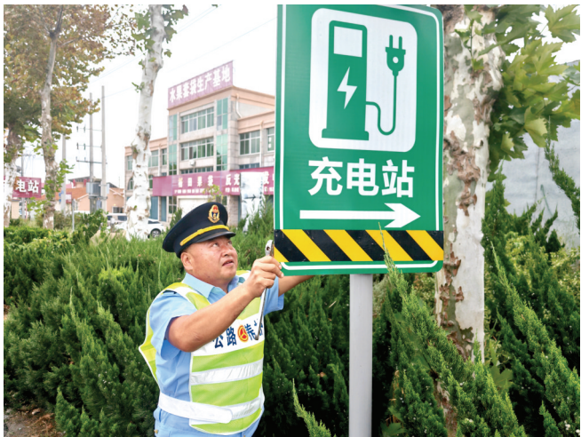
烟台公路中心工作人员排查公路设施。
