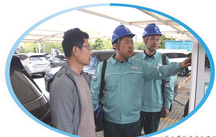
工作人员检查充电设施。
