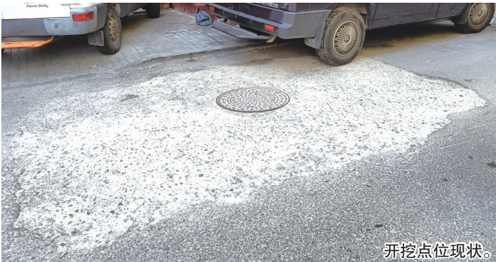
开挖点位现状。
