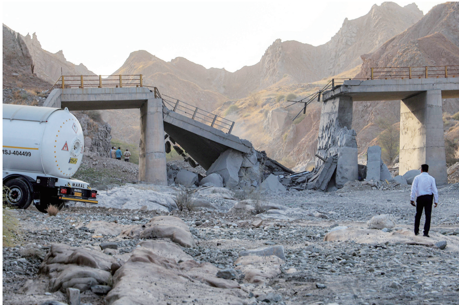
7月18日，在伊朗霍尔木兹甘省，一名男子站在一座遭空袭损毁的桥梁附近。 新华社
