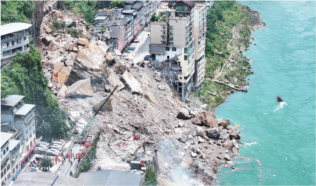
这是7月17日拍摄的重庆彭水山体垮塌现场(无人机照片)。新华社
