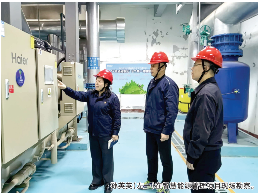
孙英英(左一)在智慧能源管理项目现场勘察。
