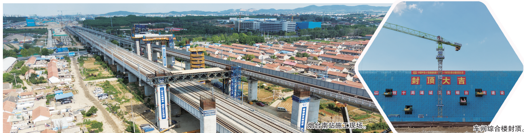
烟台南站施工现场。
