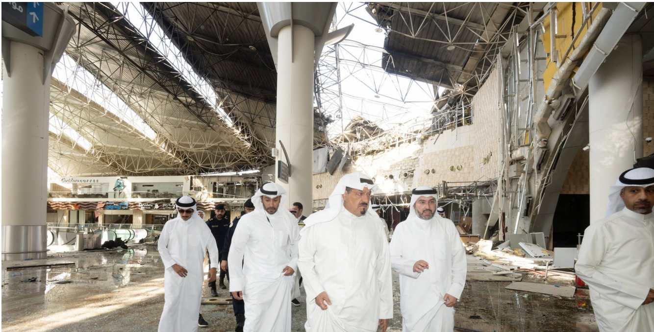
6月3日，在科威特费尔蒙瓦耶省的国际机场，科威特首相艾哈迈德(右三)视察遭袭击后的T1航站楼。科威特国防部发言人3日说，当天多架伊朗无人机袭击了科威特国际机场T1航站楼，造成该建筑严重受损和人员伤亡。
