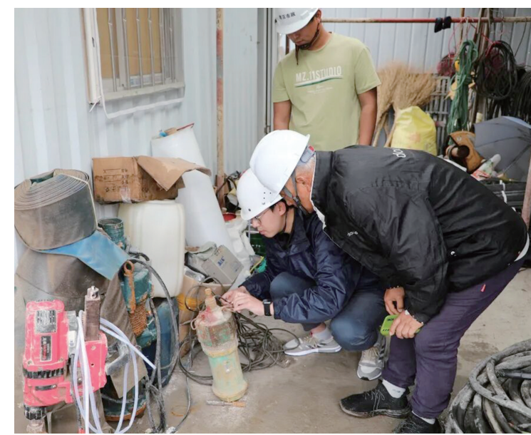
工地安全检查现场。
