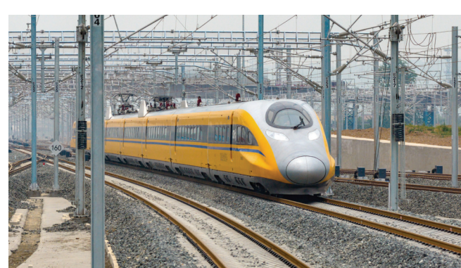
5月12日，DJ602次综合检测列车从西安东站驶出（无人机照片）。当日，DJ（动检）602次综合检测列车从西安东站平稳驶出，沿西十高铁正线穿越秦岭直达十堰东站，标志着西十高铁全线拉通试验正式启动。西十高铁是国家“八纵八横”高铁网重要组成部分。线路建成通车后，西安至十堰将实现1小时内到达，西安至武汉将实现2.5小时左右到达，对助力秦巴山区乡村振兴、推动沿线经济社会高质量发展具有重要意义。 据新华社
