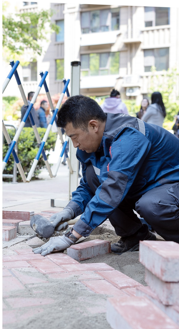
海博工程班组人员修整小区道路。
