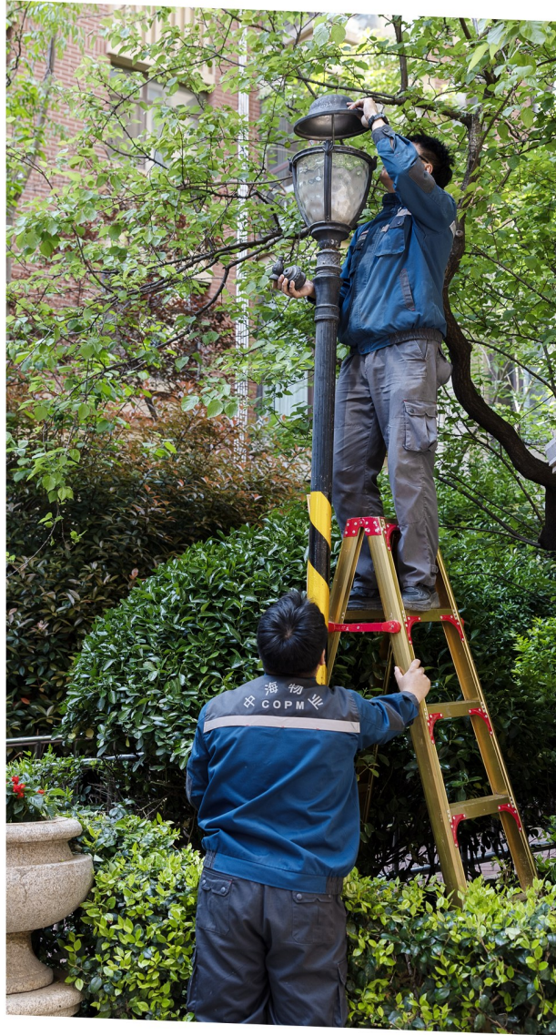
海博工程班组人员为小区更换路灯。
