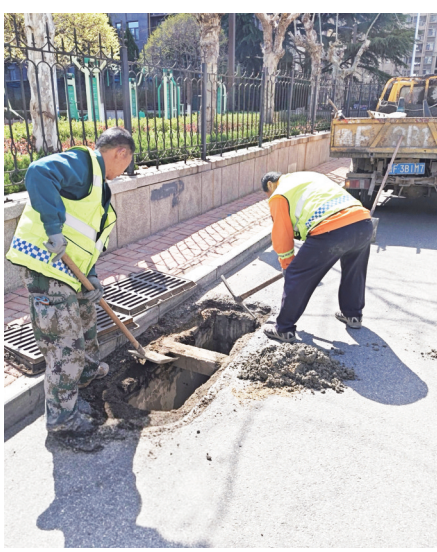
福山区环卫中心工作人员正在对路面进行精细化养护。
