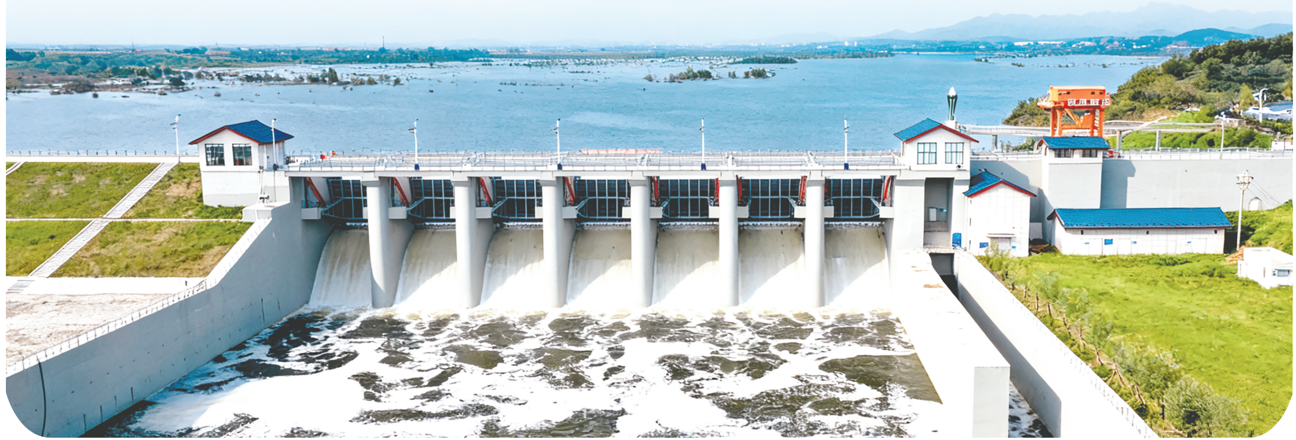
老岚水库工程。
