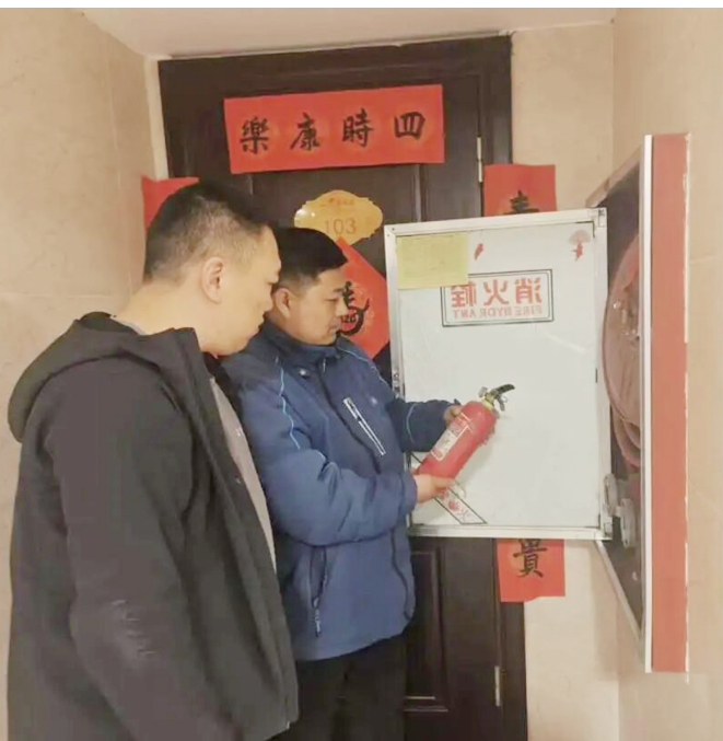
示灯故障等问题，当场督促限期整改。
