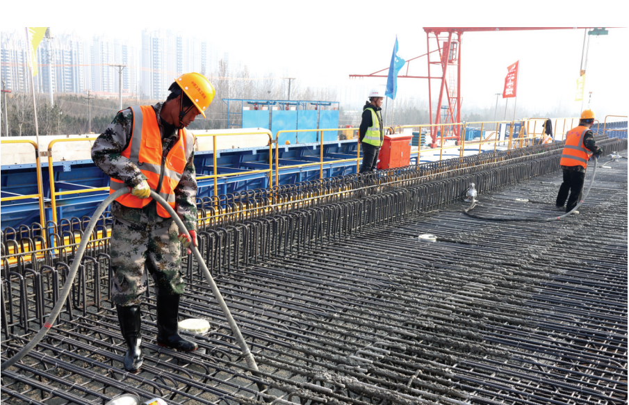
项目建设现场。
