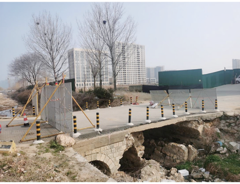
原有桥梁及现场封堵措施。
