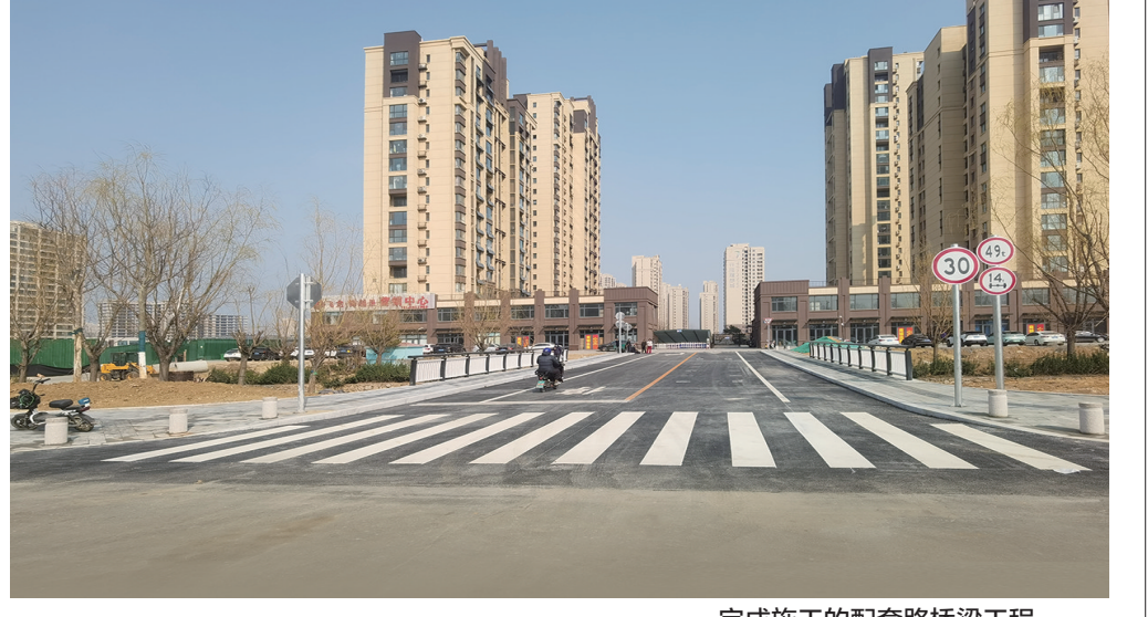
完成施工的配套路桥梁工程。
