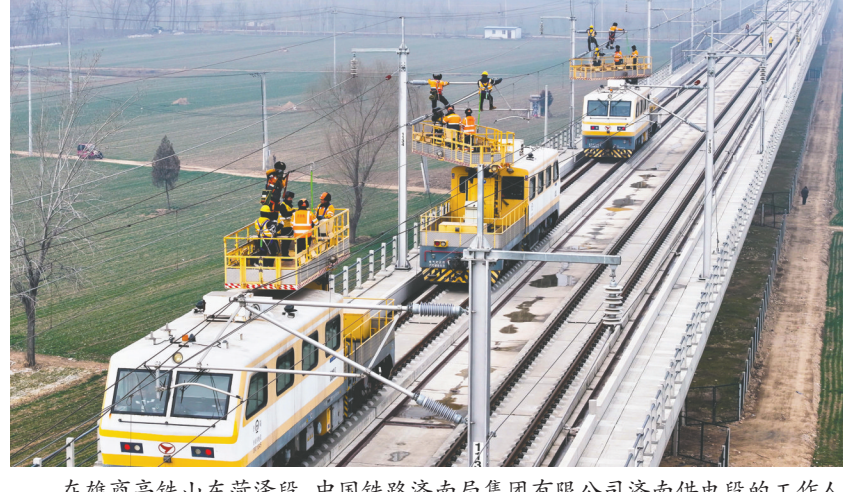
在雄商高铁山东菏泽段，中国铁路济南供电段的工作人员对接触网设备进行检查验收。新华社
